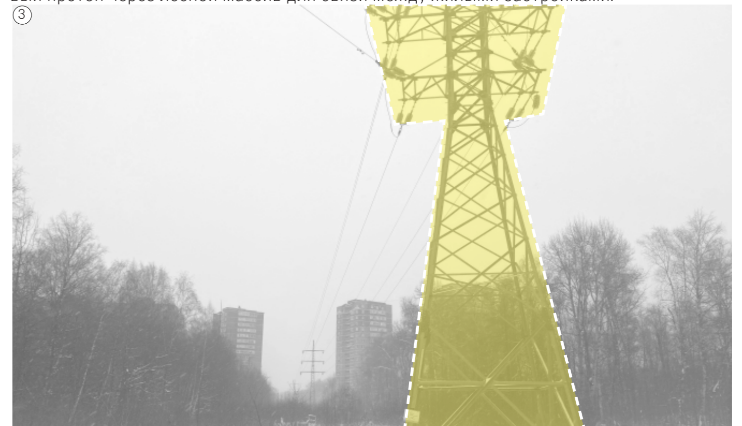
По границе территории проходит линии электропередач.
