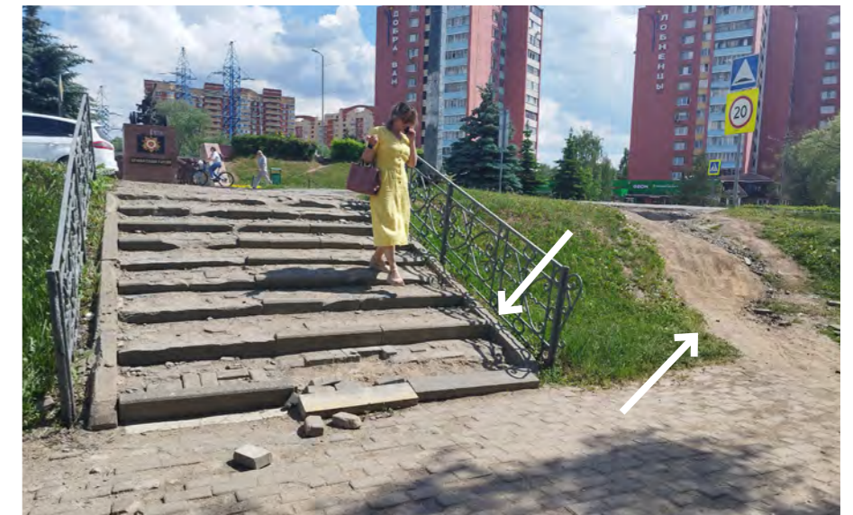
2. Лестница на главном входе
