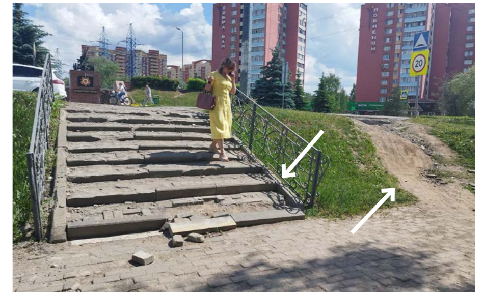
2. Лестница на главном входе
