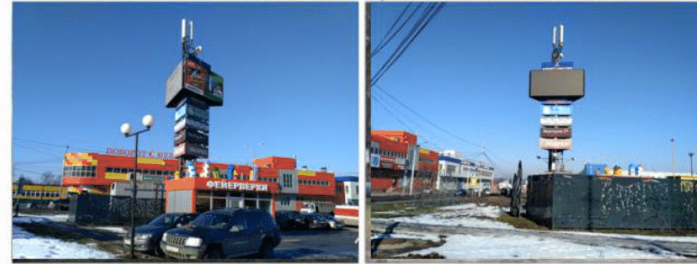
Конструкция 139 а/д. Красная Поляна-Текстильная, 0 км + 084 м, справа (Московская обл., г.о. Лобня, Краснополянский проезд, д.2)
