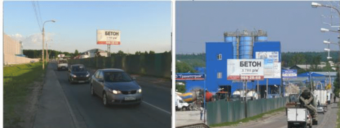
Конструкция 140 а/д. Красная Поляна-Текстильная, 0 км + 386 м, слева
