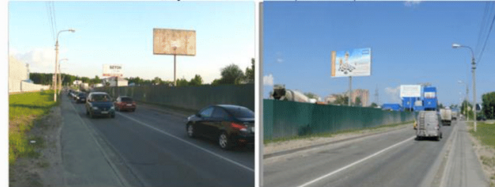
Конструкция 141 а/д. Красная Поляна-Текстильная, 0 км + 430 м, слева
